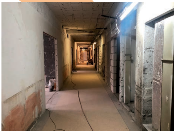
Oddział w trakcie remontu
