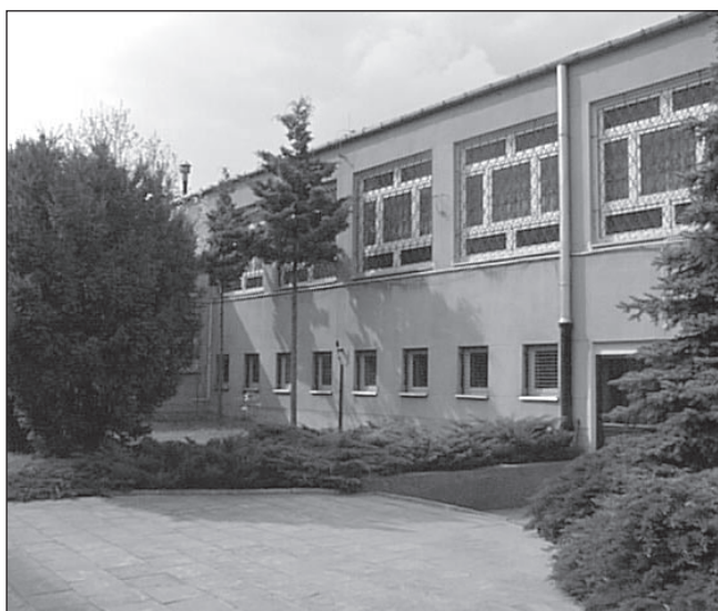
Budynek przy ul. Erazma Ciołka 27, gdzie mieszczą się zakłady: Zakład Żywienia Człowieka, Zakład Podstaw Pielęgniarstwa, Zakład Pielęgniarstwa Społecznego i Zakład Pielęgniarstwa Klinicznego
