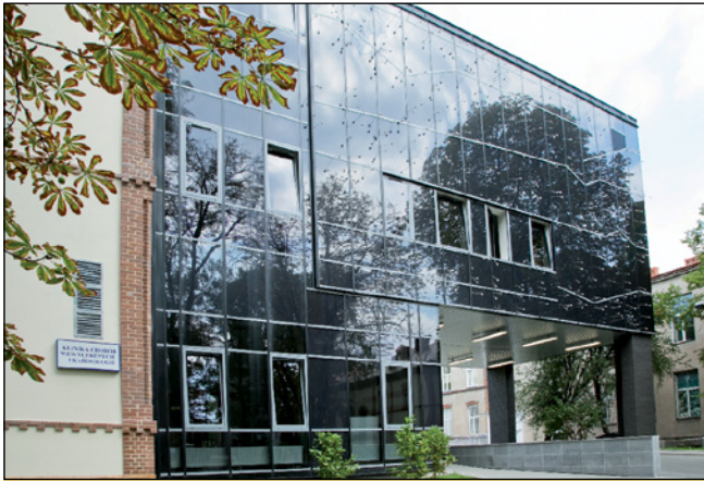
W budynku kliniki dokonano gruntownego remontu, zarówno jego wnętrza, jak i elewacji
