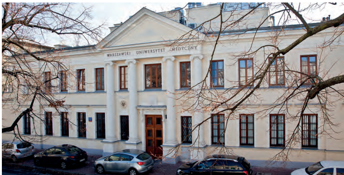
Budynek Medycyny Sądowej po renowacji
